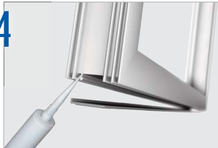
4 Fensternut mittels Silikon verkleben
