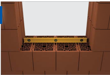
1 Fensterbankauflage auf Ebenheit prüfen und ggf. ausgleichen
